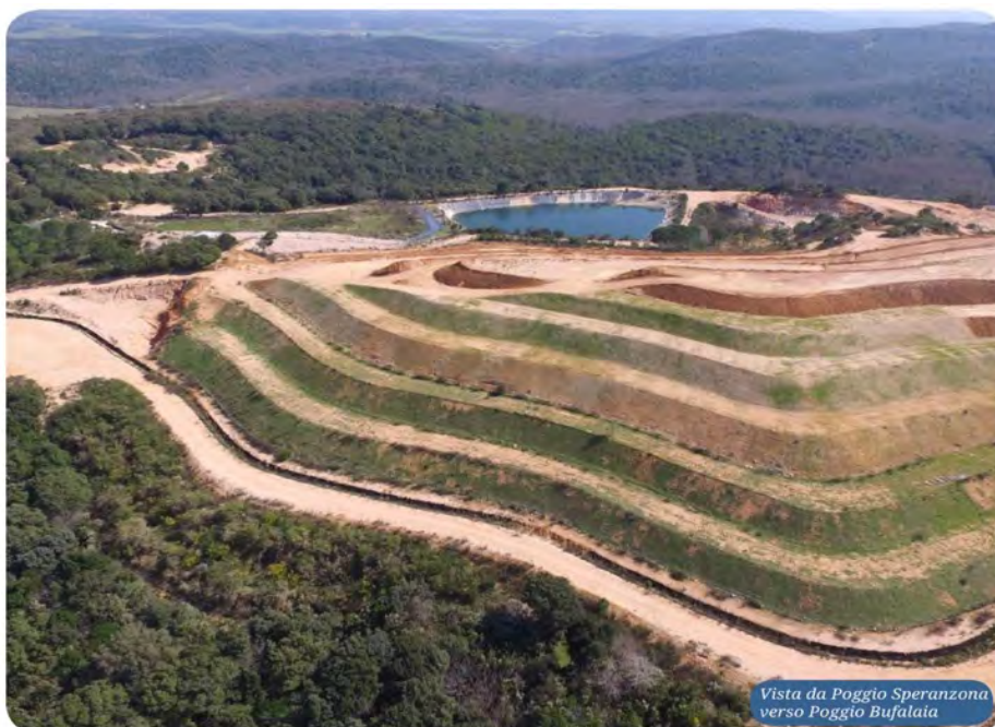
Fig. 4 – Il ripristino (in fase di completamento) dell'ex cava di Poggio Speranzona a Montioni
